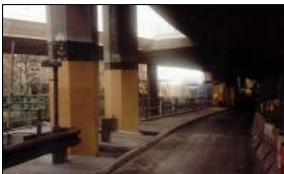
FRP column wrapping
